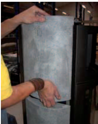
12. Montieren der oberen Seitenkachel.
