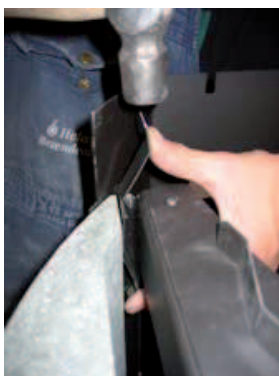
13. Montieren der Klammern für die obere Seitenkachel.
