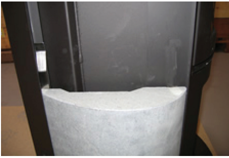
10. Anbringen der Klammern bei der unteren Kachel, bereit für die nächste.
