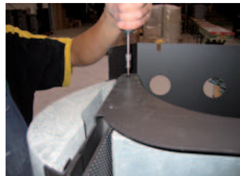
24. Den hinteren Schrauben auf beiden Seiten der Topplatte abmontieren.
