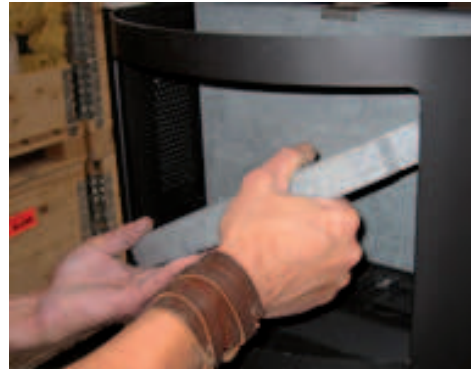
22. Montage der Bodenplatte im Warmhaltefach.
