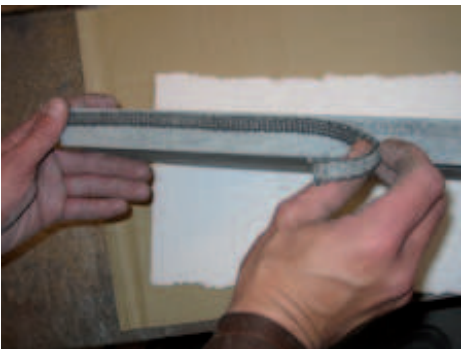
20. Unter der Kachel im Warmhaltefach das beiliegende Dichtungsband angekleben (stoßabsorbierend).
