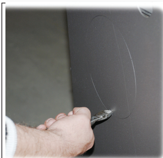
Fig. 1 Klip det lille stykke metal over, der forbinder dækslet med bagpladen med en skævbider. Vrid derefter dækslet af.
