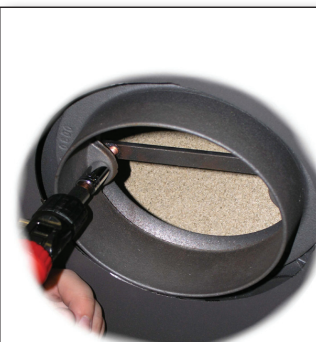
Fig. 8 Sørg for, at røgtuden sidder centreret og spænd herefter boltene
